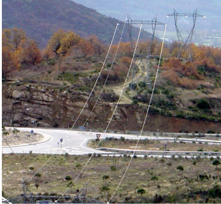
Fig. 4.- Si la velocidad de arrastre de los electrones libres fuera próxima a la de la luz, en cada hilo de una línea eléctrica aérea se ejercerían toneladas de fuerza hacia abajo debidas a la fuerza centrífuga de los electrones al tener que seguir la catenaria.
